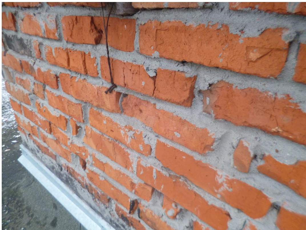
Фото 4. Разрушение кирпичной кладки в будке выхода на кровлю.
