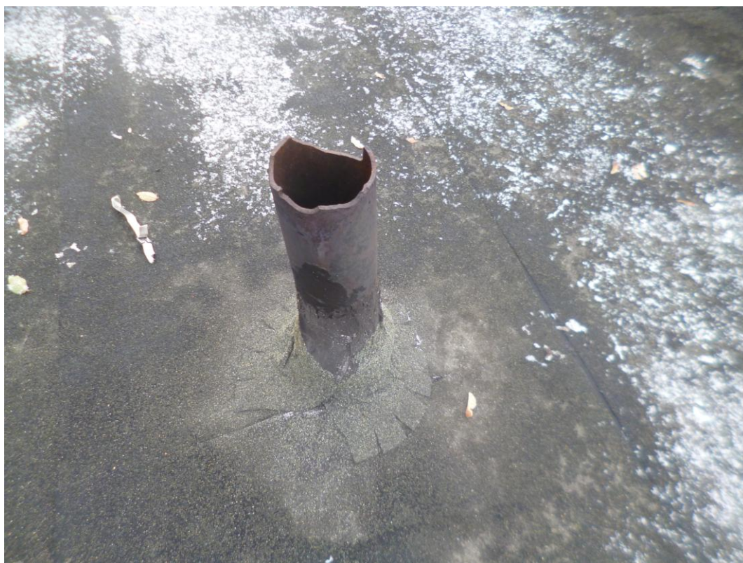
Фото 7. Разрушение фановых труб и примыкания кровельного ковра.
