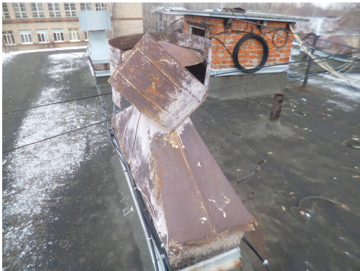
Фото 6. Разрушение и коррозия дефлекторов.
