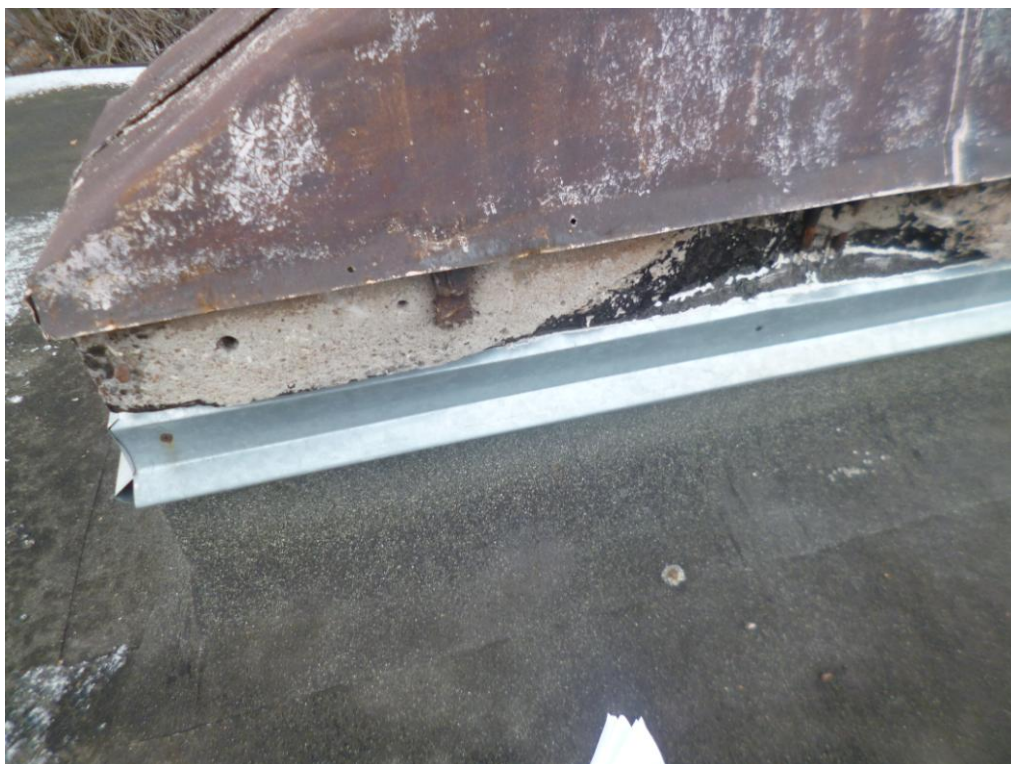
Фото2. Вентканалы, разрушение бетонного слоя и оголение арматуры.
